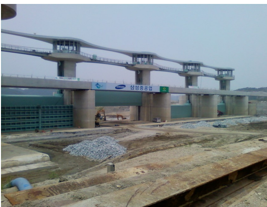
Abb 1: Schleusentore im Bau
