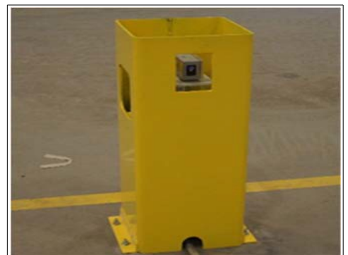
Abb 2: Dimetix Laser montiert
